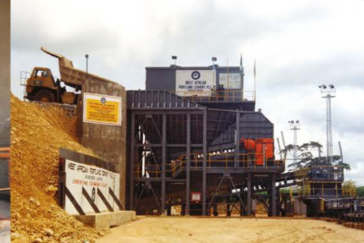
Wapień | Nigeria | Nadawa: 1000mm | Produkt końcowy: -200mm | Wydajność: 400 t/godz
