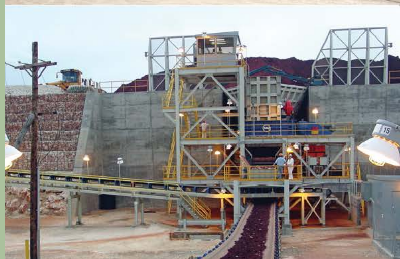
Бокситы | Ямайка | Вход: ROM | Выход: -150мм | Производительность: 1600Тонн/час
