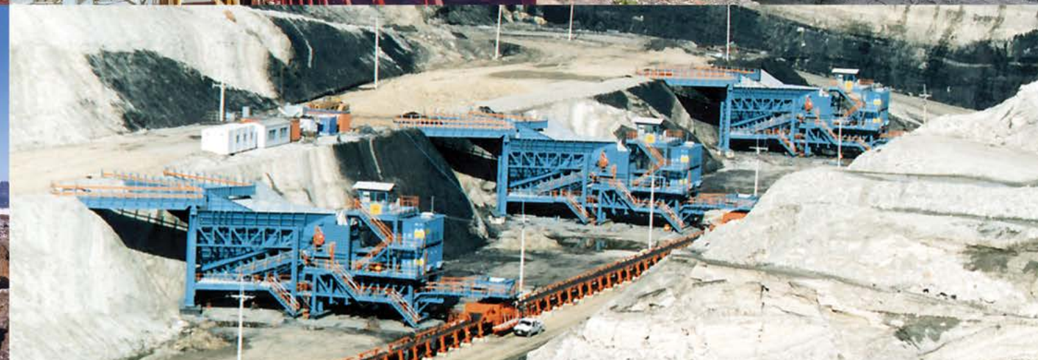
Вскрыша | Таиланд | Вход: 1500мм | Выход: -300мм | Производительность: 4500Тонн/час
