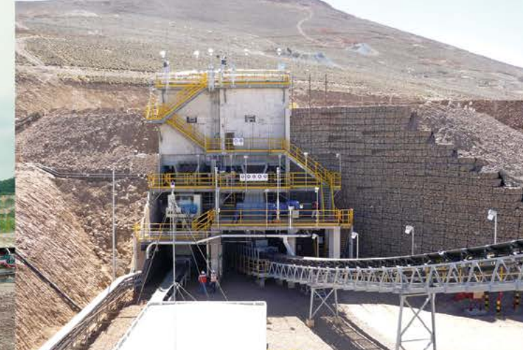
Срібна руда | Болівія | Вход: 750мм | Выход: -150мм | Производительность: 600Тонн/час
